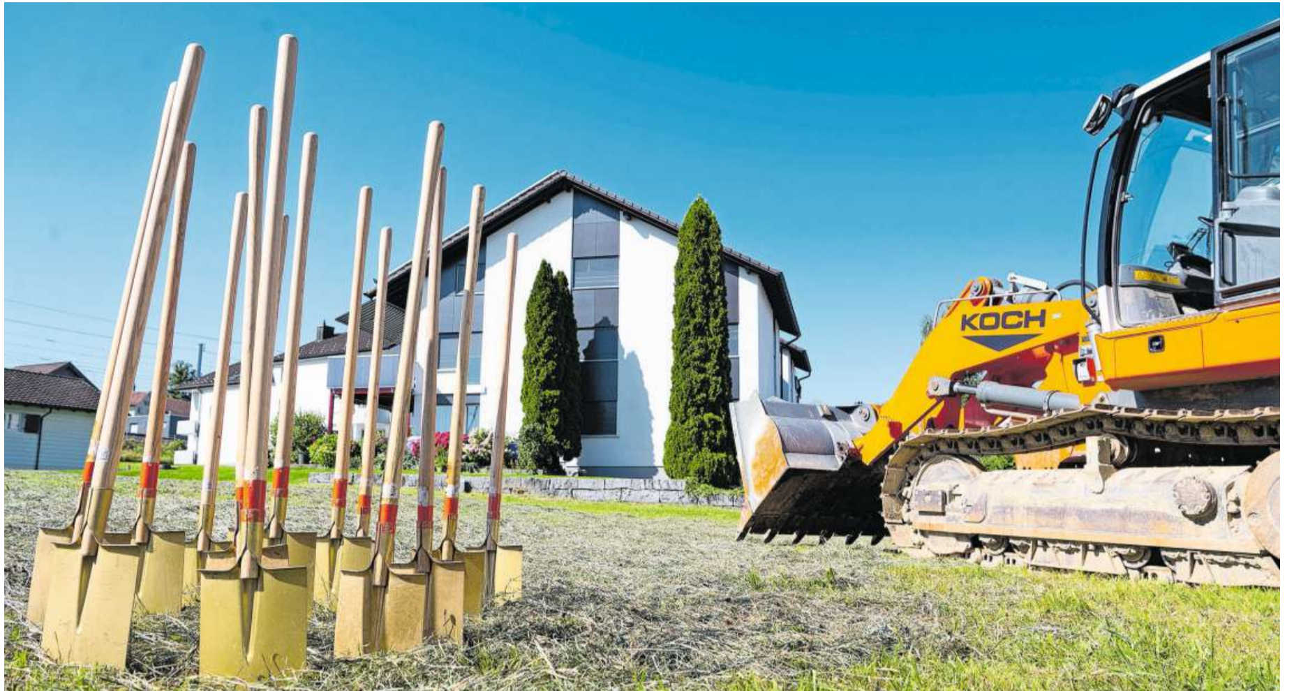
Ab nächster Woche verwandelt sich das 4600 Quadratmeter grosse Grundstück an der Bedastrasse in eine Baustelle.
