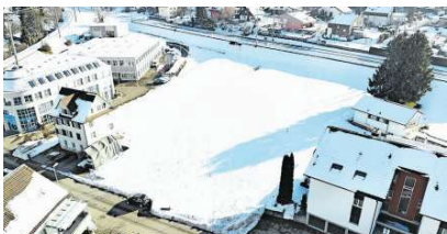
Vor rund einem Jahr wurden die Bauvisiere gesteckt – nun ist die Baubewilligung für das Projekt an der Bedastrasse da. Das Wohnhaus links unten in der Ecke wird abgerissen. Bild:Andri Wöhinger (13. Dezember 2021)
